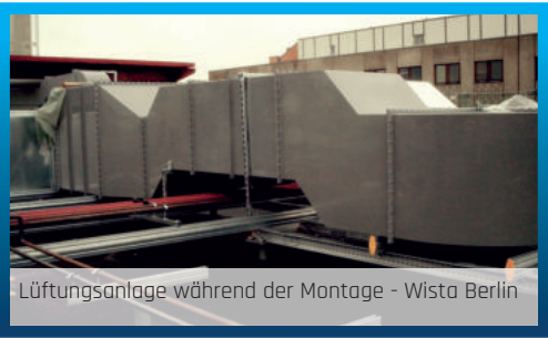
Lüftungsteile im Labortrakt während der Montage Wista Berlin
